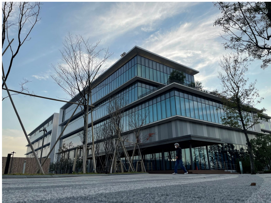
Shimadzu Tokyo Innovation Plaza (2022年10月開所予定) 殿町キングスカイフロント内 (神奈川県川崎市)
