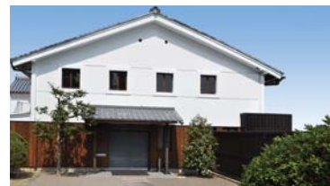
新しくなったエントランス
