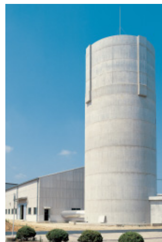
流量計校正試験所 外観
