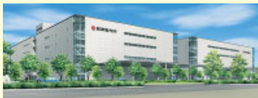
平成19年12月竣工予定のターボ分子ポンプ新工場 鉄筋4階建て、延床面積 16,000m 2
