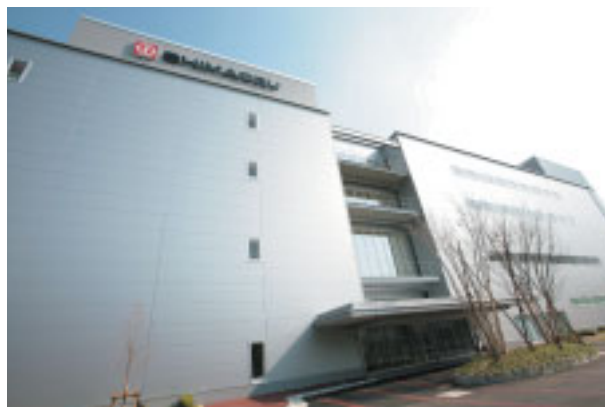
完成した分析計測機器の新工場
