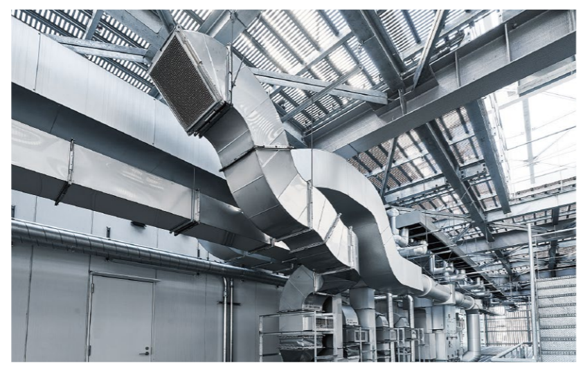
Shimadzu Tokyo Innovation Plaza/ 殿町事業所に設置されているドラフトチャンパー。給排気のコントロールを行い、ラボ内の環境を良好に保っている。
